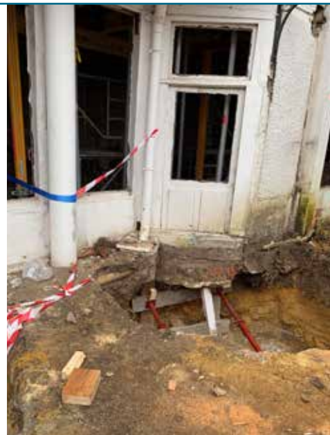
L'état du bâtiment, abandonné depuis plusieurs années, nécessite des démolitions, de gros renforts, en fondations, murs et charpente. L'isolant Gramitherm a été posé partout où c'était possible, les solutions validées par des études Wufi.
