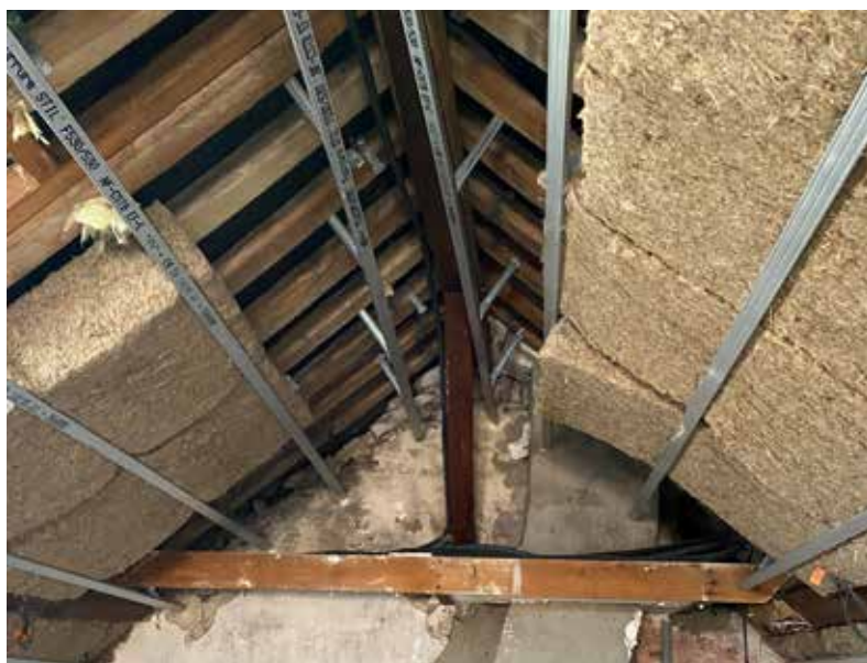
L'état du bâtiment, abandonné depuis plusieurs années, nécessite des démolitions, de gros renforts, en fondations, murs et charpente. L'isolant Gramitherm a été posé partout où c'était possible, les solutions validées par des études Wufi.
