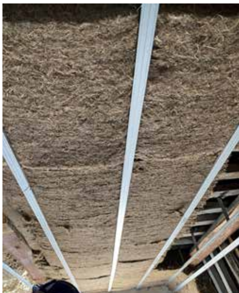
Une fois les gestes acquis, l'isolant à base d'herbe s'est révélé agréable et rapide à poser.
