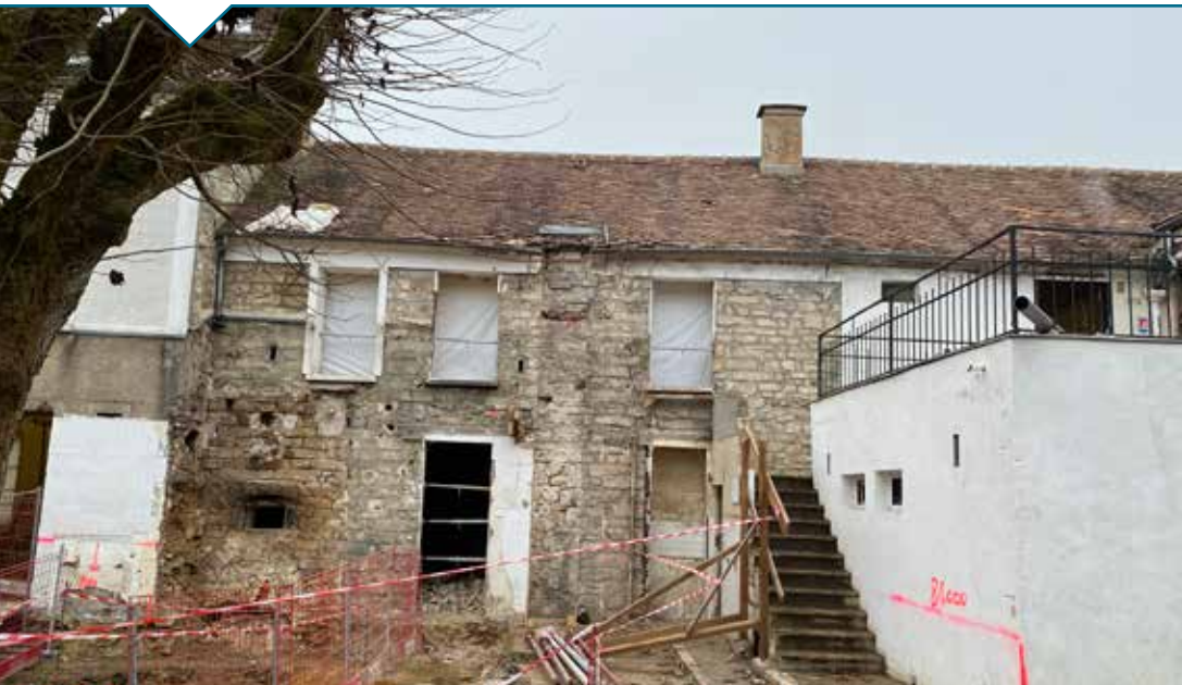
L'état du bâtiment, abandonné depuis plusieurs années, nécessite des démolitions, de gros renforts, en fondations, murs et charpente. L'isolant Gramitherm a été posé partout où c'était possible, les solutions validées par des études Wufi.
